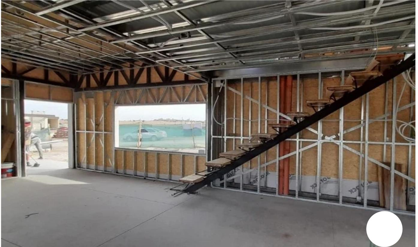
Uno de los sistemas de construcción en seco que se viene utilizando más en Argentina, es el steel frame. Foto. Gentileza Grupo Edisur
